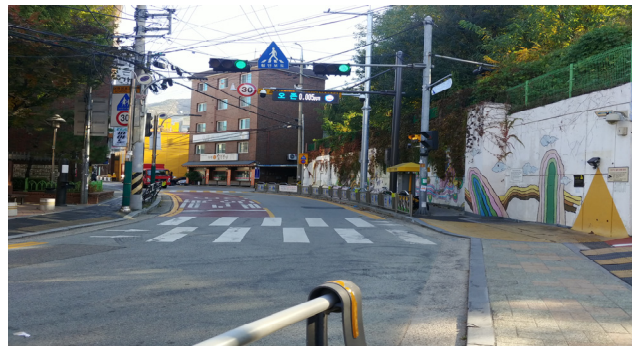
[진입로 기준 북동측 9m 도로]
